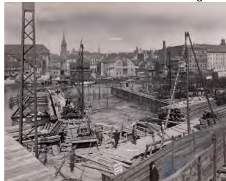
Baugrube Spreetunnel Linie A
