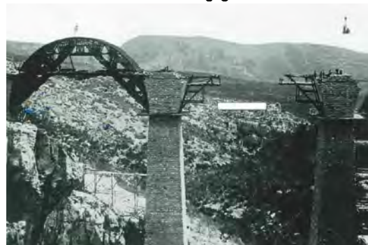
Bau der Bagdadbahn – Teilstrecke am Viaduct Giadere
