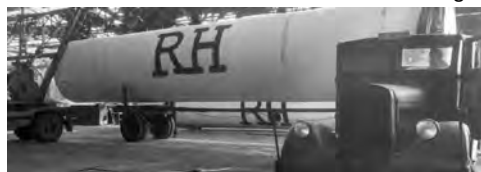
Anlieferungen für die neue Heizzentrale der Mix & Genest (BBWA U 5/2)
