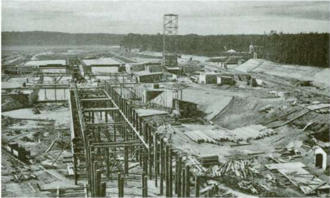
Bau des Teltow-Kanals 1904, Schleuse Kleinmachnow
