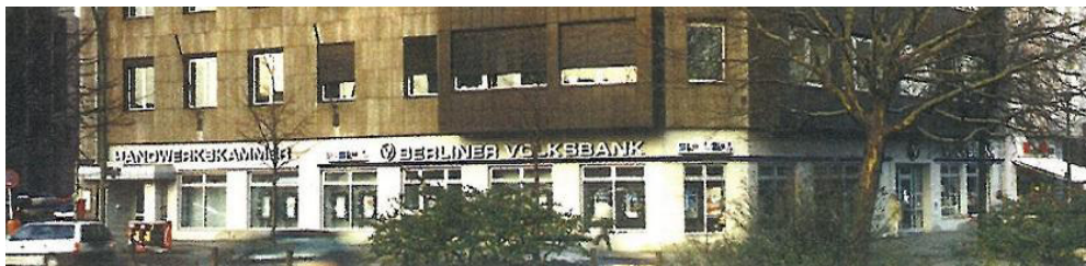
Ansicht der Handwerkskammer 1950 (Faltblatt aus dem historischen Bestand der Handwerkskammer)
