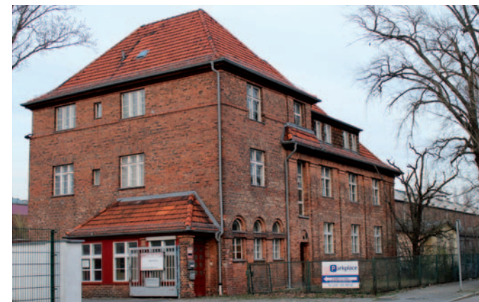
Verwaltungsbau der AG Lauchhammer (1922 von Walter Klingenberg)
