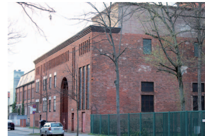
Um- und Abspannwerk Wittenau in der Breitenbachstraße
