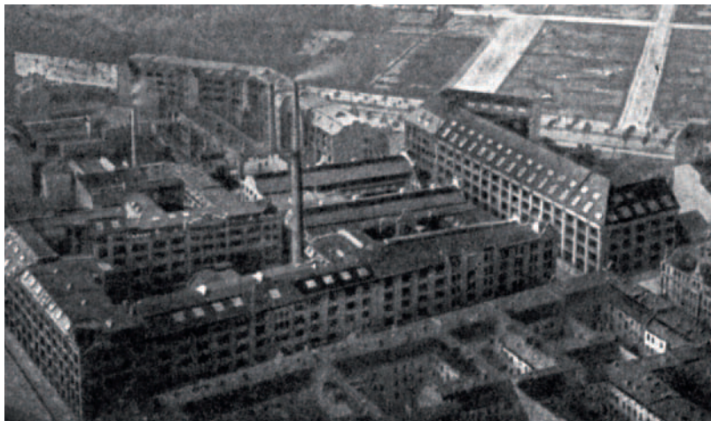
Die Werksanlagen der Bergmann Elektrizitäts-Werke AG in der Seestraße in Wedding
