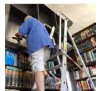
Aufbau der Regale in luftiger Höhe
