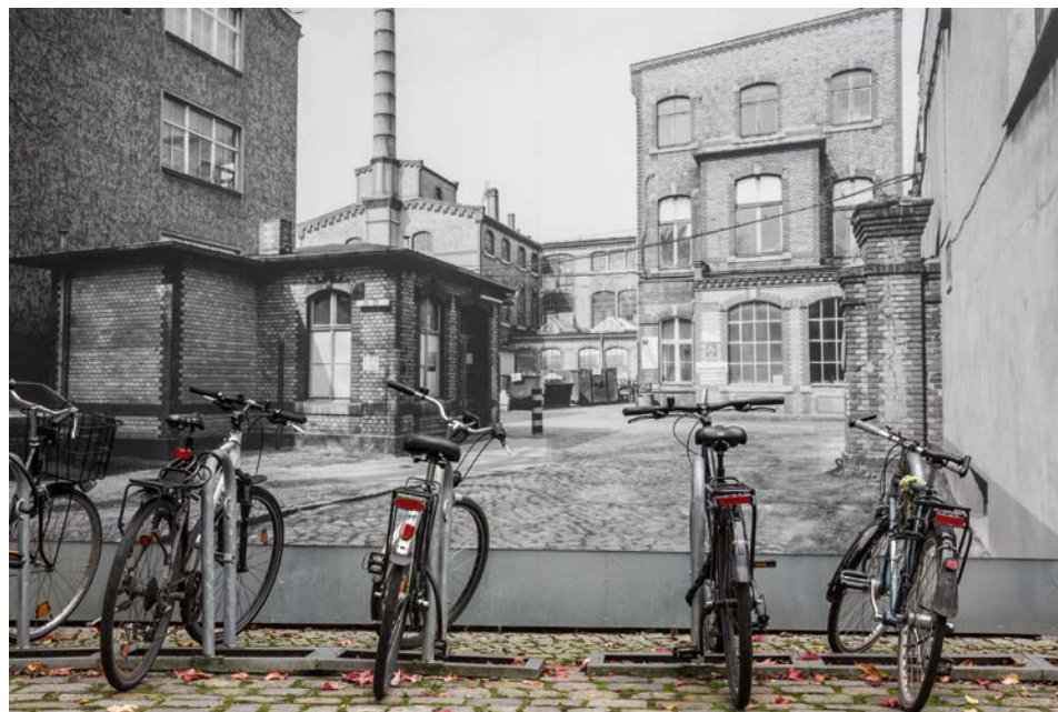
Schraubenfabrik Schwartzkopff (Lohmann & Birkner Health Care Consulting GmbH) Außenansichten
