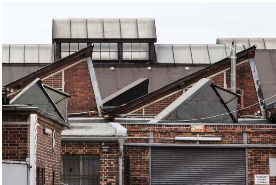
Gewerbehof Flottenstraße (GSG) Ansichten im Hof
