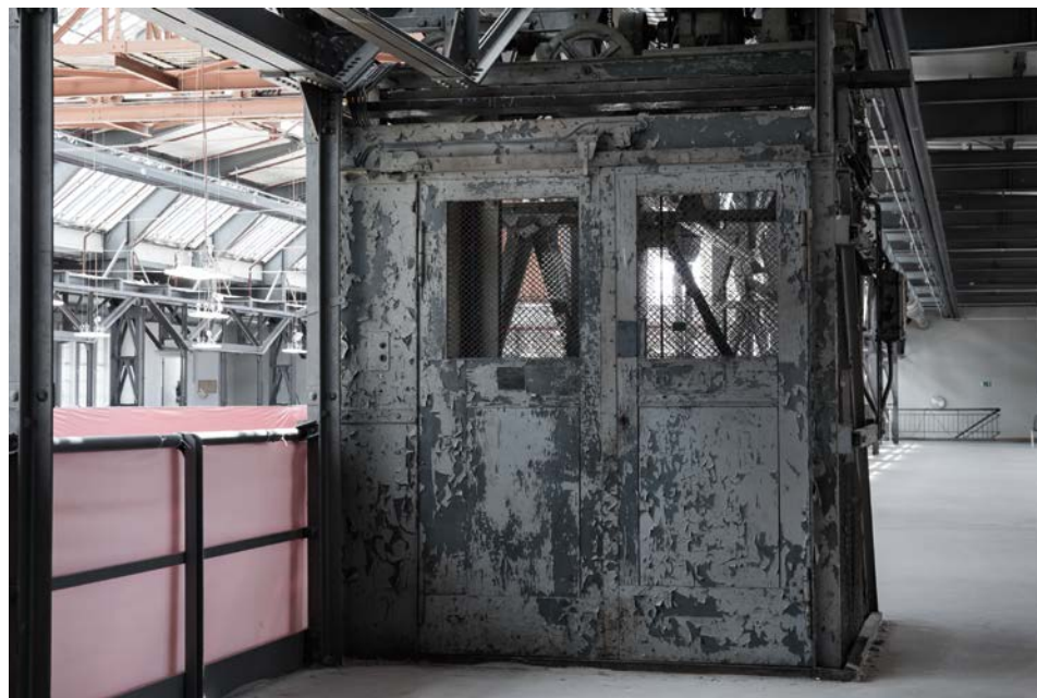
Maschinenfabrikhalle Schoening (Einzelhandel) Innenansichten
