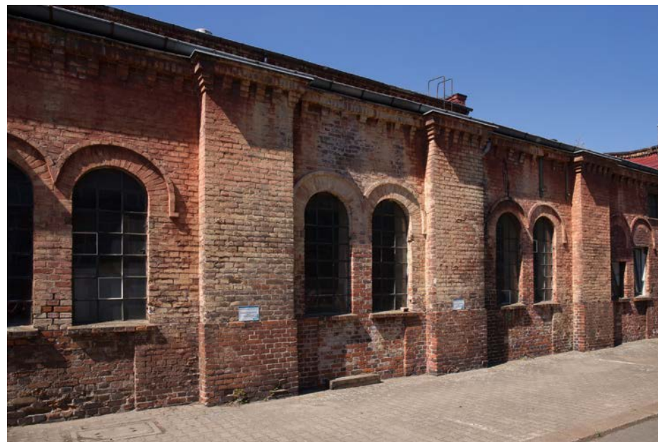
Borsig, Germaniahalle Außenansichten
