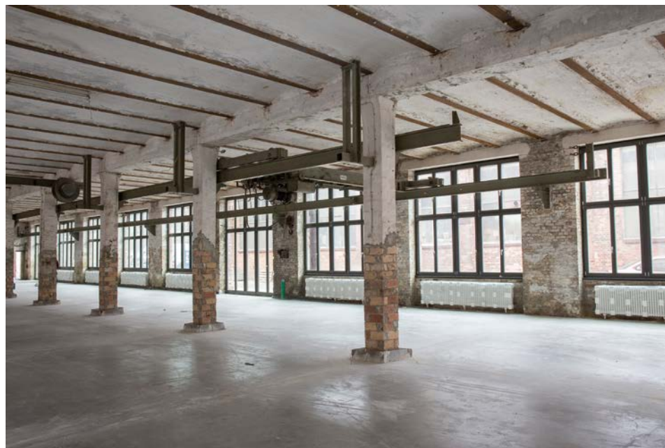
Eisengießerei Winkelhoff (Wilhelm-Hallen) Im Juni 2020: Einfahrt, Innenansicht Werkhalle im Umbau
